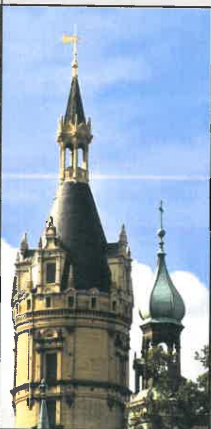
Hochpunkt (Turm, Knopf u. a.)
