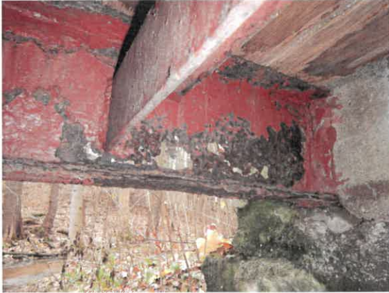
ANBINDUNG DES QUERTRÄGER GERING KRAFTSCHLÜSSIG
