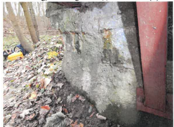
WIDERLAGER VORN AUSSINTERUNGEN MEHRFACH
