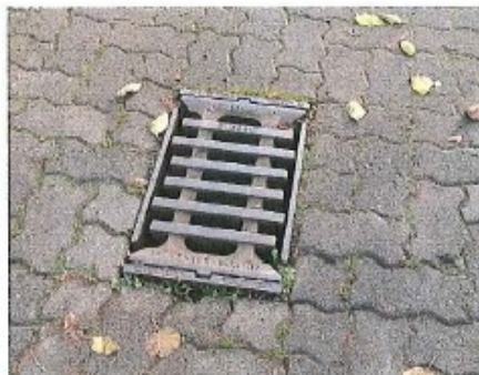
Unzureichende Bodeneinläufe, abgesenkte Pflasterung, ordnungsgemäßer Abfluss nicht gewährleistet
