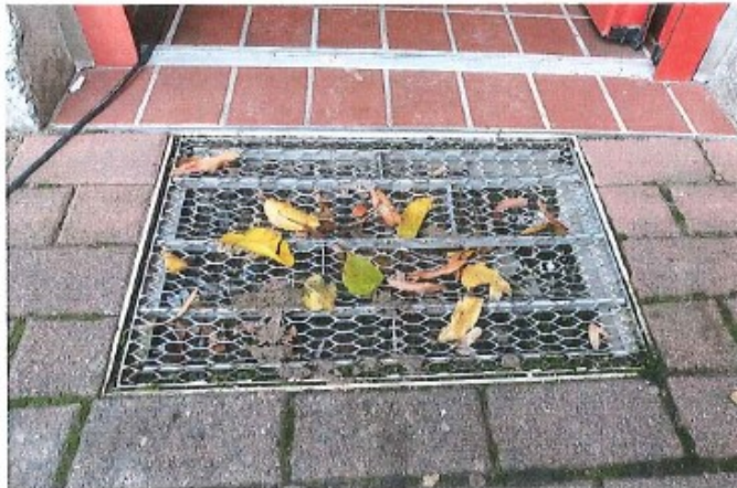
Defekte Abdeckung (Rost) des Fußabstreifkastens, dadurch uneben
