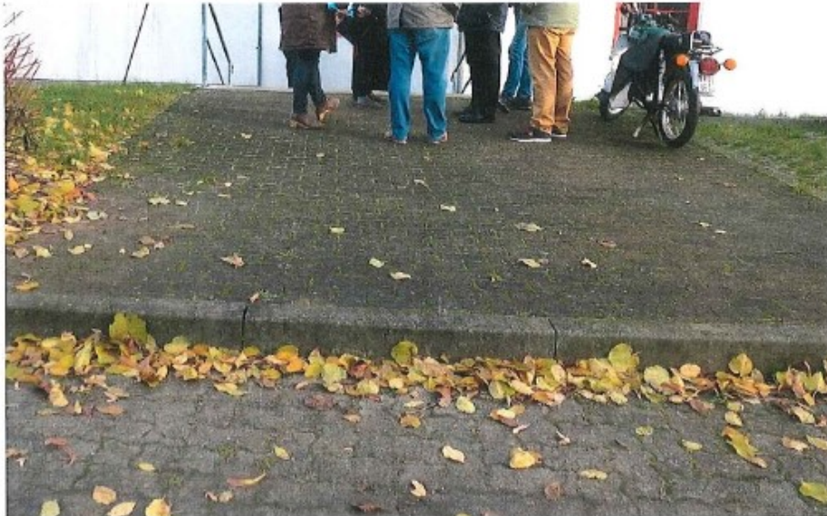
Fehlende Absenkung der Bordsteinkante im Alarmweg
