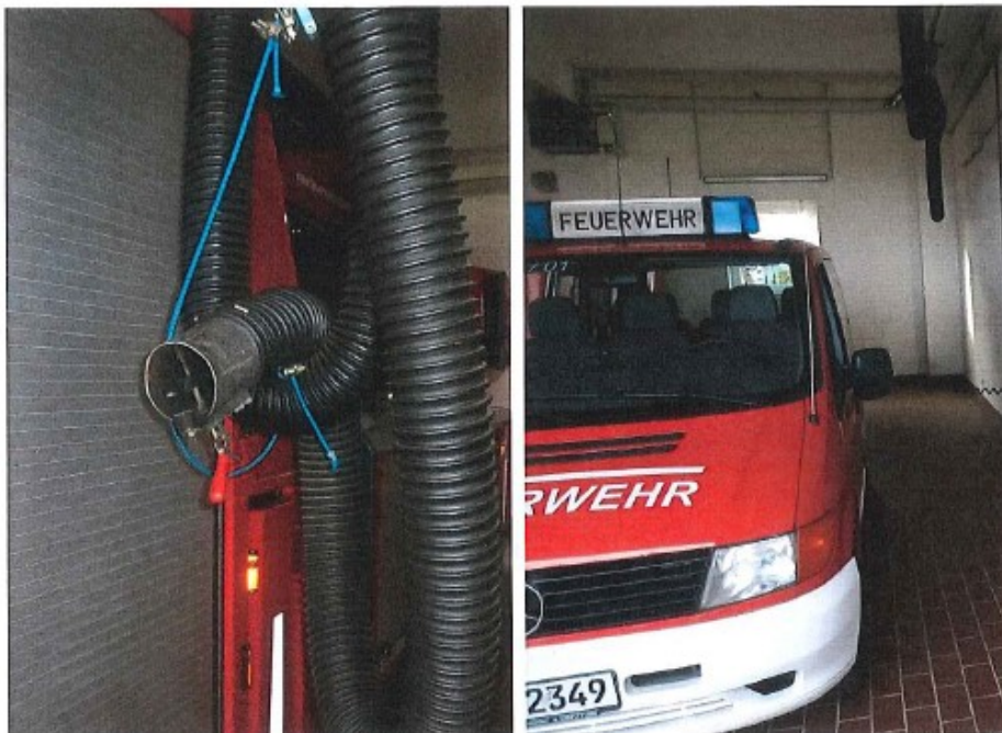
Abgasabsaugung nicht angeschlossen (DL und ELW)
