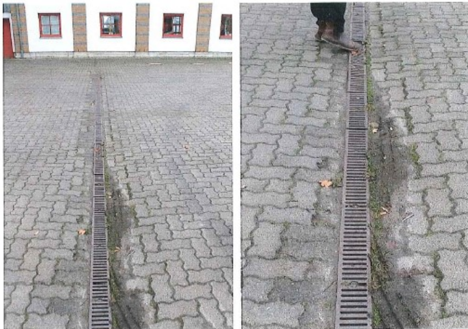
Unzureichende Funktion der Ablaufrinne, Stolper und Ausrutschgefahren
