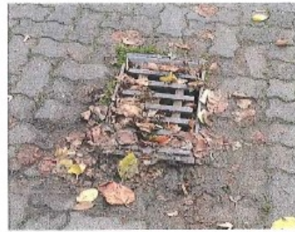
Unzureichende Bodeneinläufe, abgesenkte Pflasterung, ordnungsgemäßer Abfluss nicht gewährleistet
