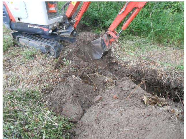
Abb.10: w. v., Grabenerweiterung
