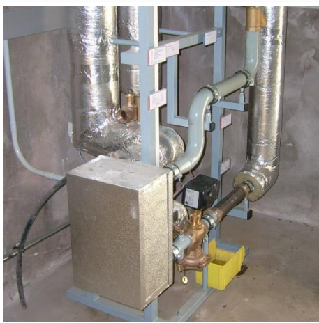
Abb. 28: Wärmeübergabestation
