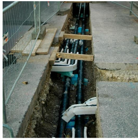
Abb. 27: Nahwärmeleitungen
