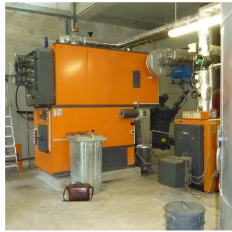
Abb. 25: Holz-Hackschnitzelkessel
