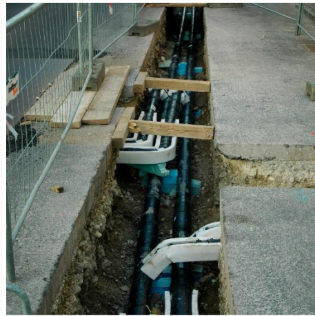
Abb. 29: Nahwärmeleitungen
