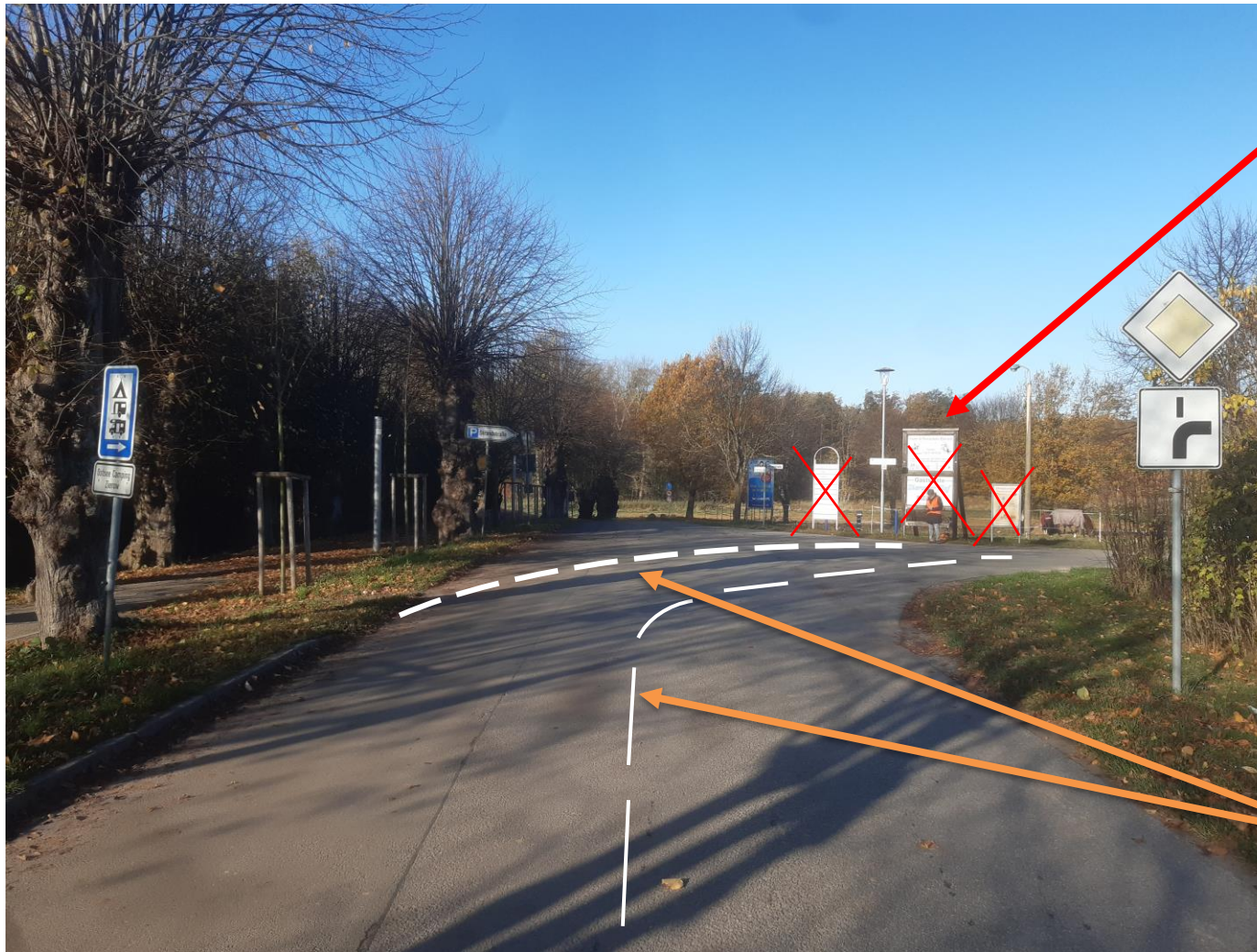
Abbildung 19: Maßnahmen Knoten 2: Beschilderung und Fahrbahnmarkierung
