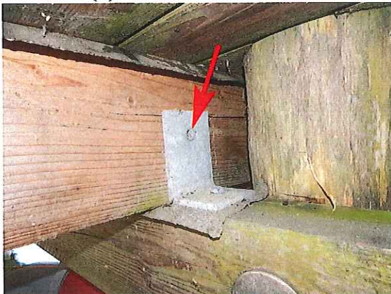
KLWI901_B_2019H_LT-4 A-2 LINKS BOLZEN FEHLT
