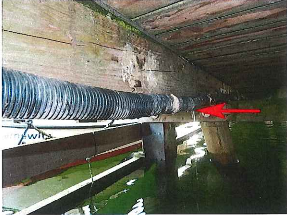
KLWI901_A_2019H_LEITUNG LT-2 F-2 SCHUTZROHR MIT WASSER GEFÜLLT
