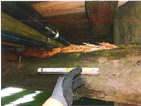
KLWI901_A_2019H_QT-10 VORNE MITTIG OBEN ANGEFAULT
