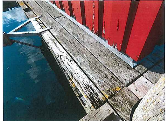
KLWI901_B_2019H_BELAG HAUS-4 HINTEN ANGEFAULT
