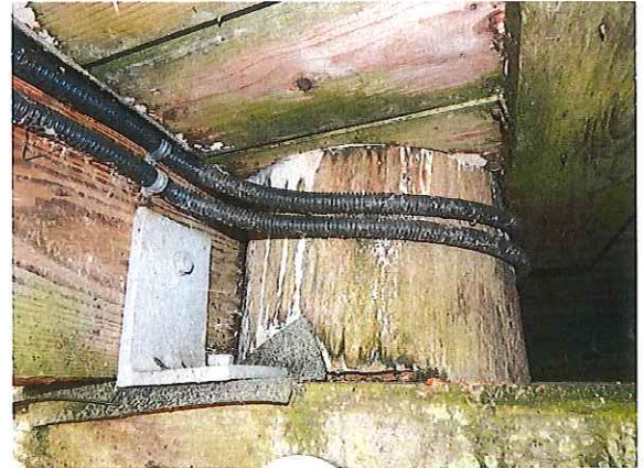
KLWI901_A_2019H_ST-2 A-12 HINTEN PILZMYZEL
