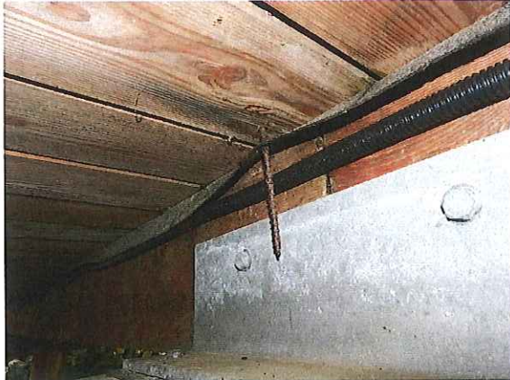
KLWI901_B_2019H_BELAG UNTEN A-3 LT-4 SCHRAUBE HERAUSSTEHEND
