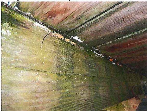
KLWI901_A_2019H_LT-2 F-4 RECHTS PILZMYZEL MIT FRUCHTKÖRPER
