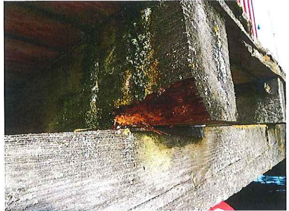
KLWI901_B_2019H_LT-7 A-16 BALKENKOPF ANGEFAULT
