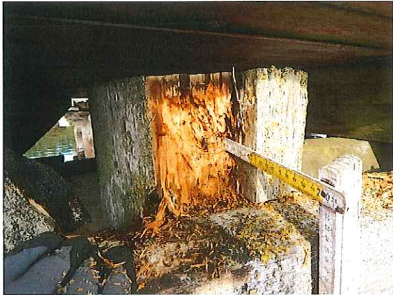
KLWI901_A_2019H_ST-3 A-16 PFAHLKOPF ANGEFAULT
