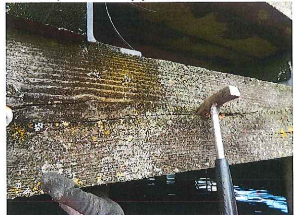
KLWI901_A_2019H_QT-16 HINTEN GERISSEN ANGEFAULT
