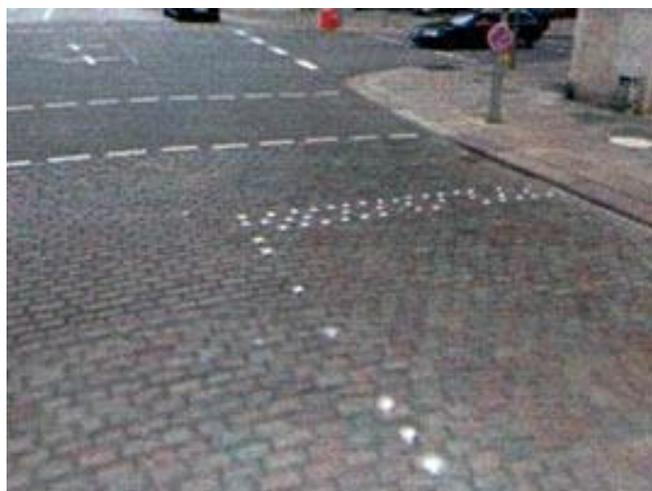
Abbildung 3: Beispiele für Markierungsnägel
