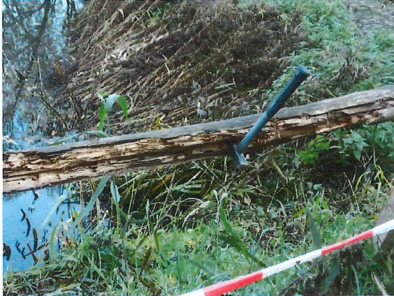
ZIER002_2015H_GEL-LI-VERMODERTER-HANDLAUF
