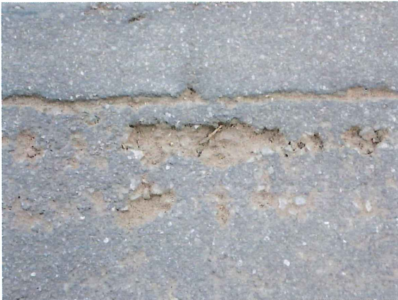
ZIE002_2015H_AUSWASCHUNGEN-ASPHALT-MIT TIG
