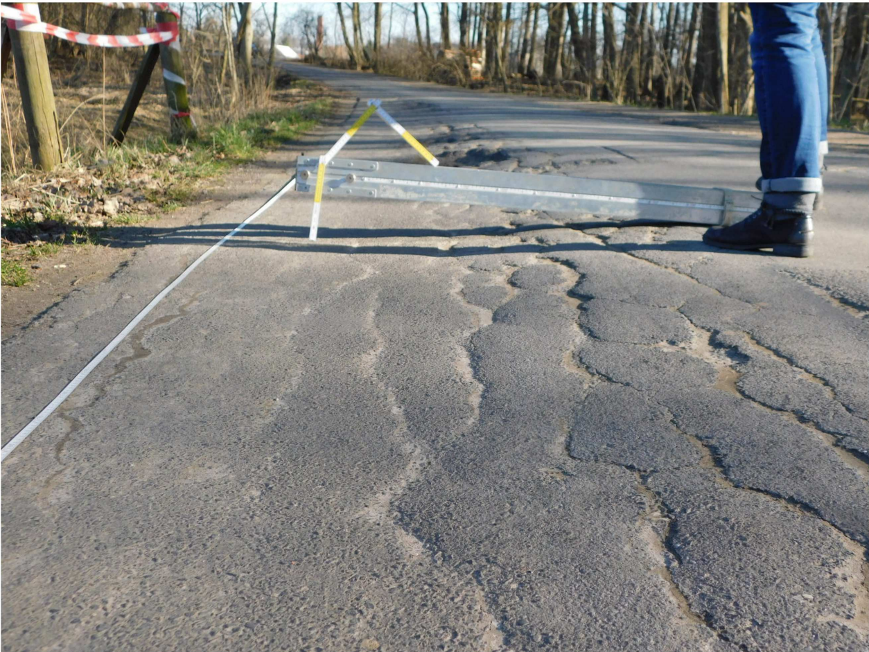
015_2019-02-27_Fahrbahn im Bereich Brückenbauwerk
