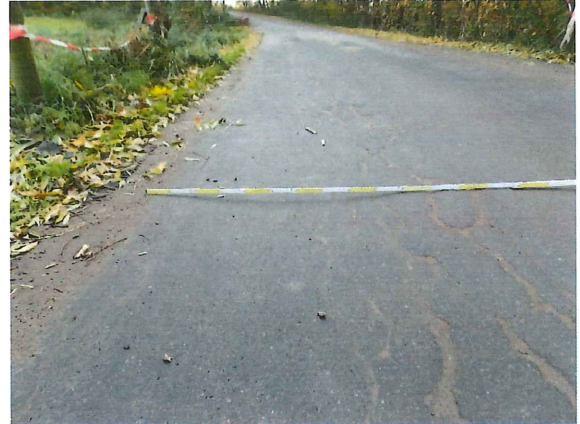
ZIER002_2015H_RE-FAHRBAHN-ABSACKUNG-3CM
