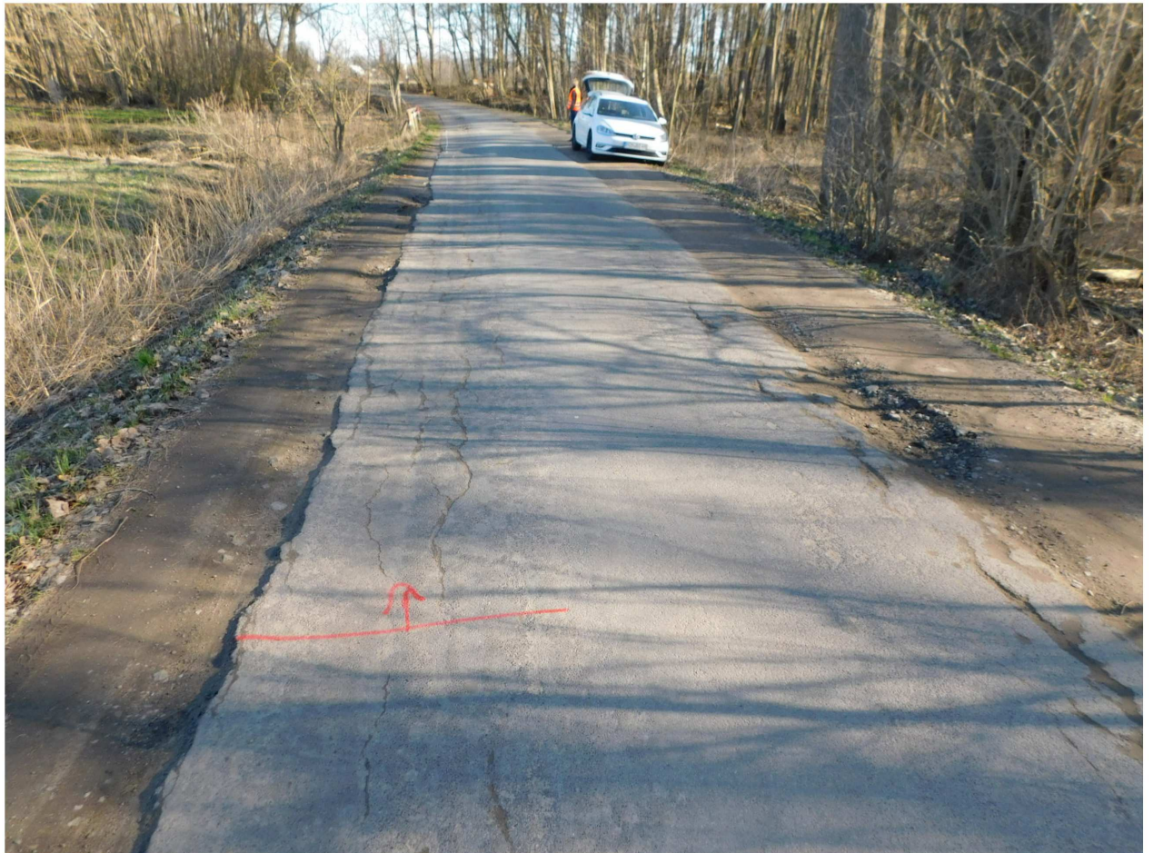
013_2019-02-27_Übersicht Fahrbahn von Eggerstorf
