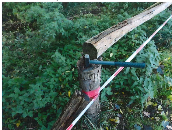
ZIER002_2015H_GEL-LI-VERMODERTER-PFOSTEN
