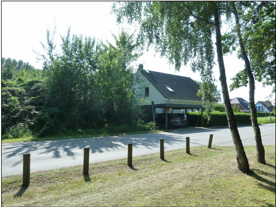
Abb. 1: Ansicht des Grundstückes Tarnewitzer Huk Nr. 18 von der Hauptverkehrsachse (Quelle: Planungsbüro Mahnel, Stand: 29. August 2017).
