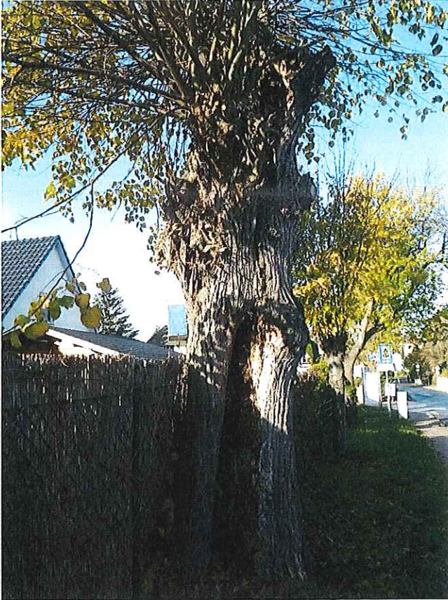
Foto 7: Baum 26 mit völlig hohlem Stamm.
