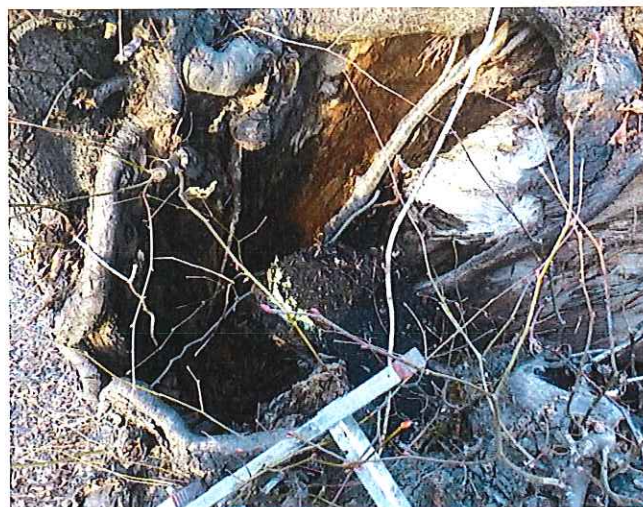
Foto 5: Blick in Baum 46.
