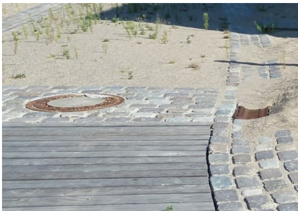
Abb. 8: Befestigung der privaten Erschließungswerge
