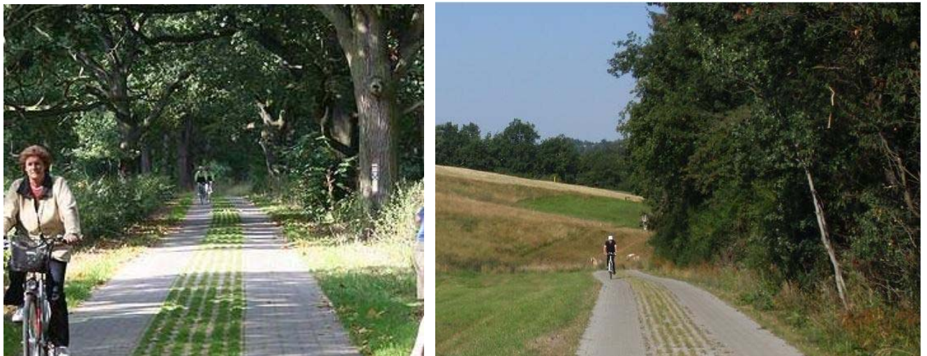
Betonplatten mit Rasengitter
