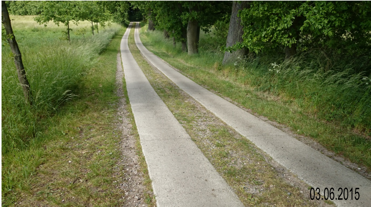
Betonspurplatten aus Ortbeton
