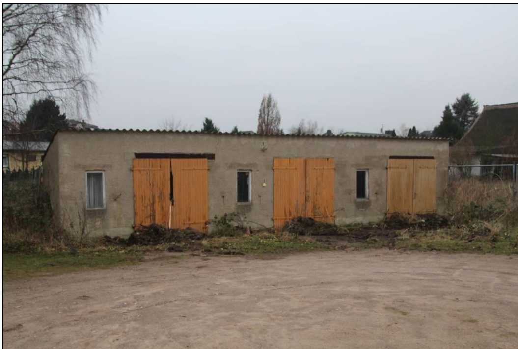
Abbildung 5: Garagen im Plangeltungsbereich (Abbruch geplant)
