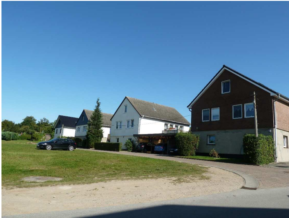
Abb. 22: Am Mühlenberg Nr. 5, 5a, 5b, 5c
