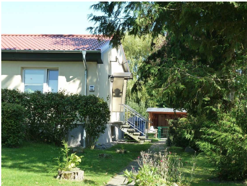
Abb. 32: Klützer Straße Nr. 13 (mit erhöhtem Sockel)
