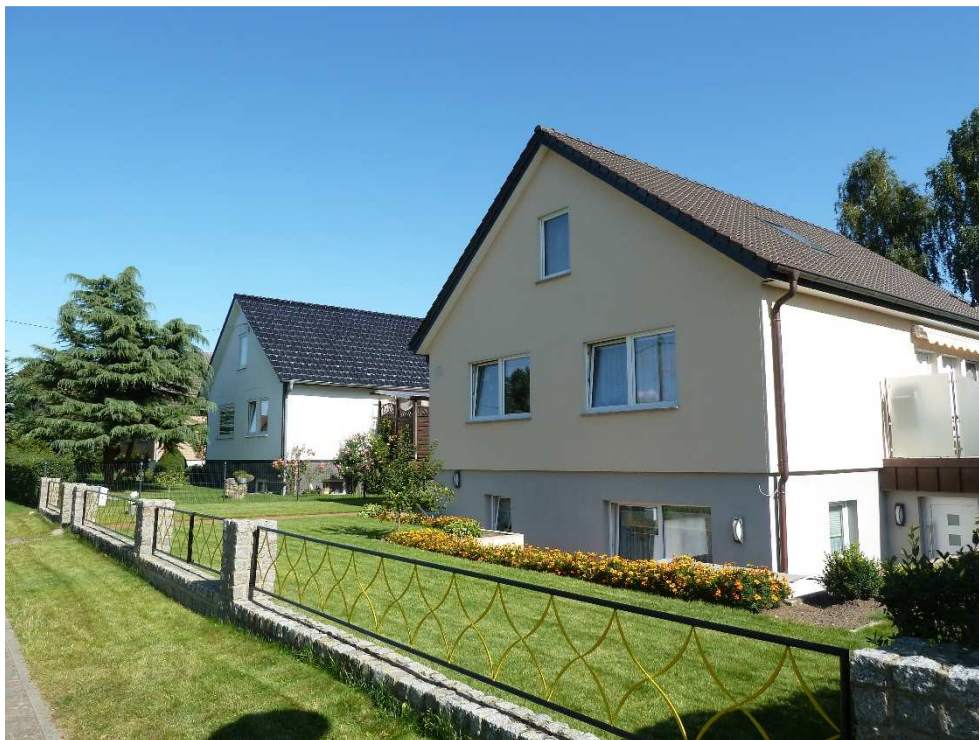
Abb. 13: Einfriedungen zur öffentlichen Straße (2)
