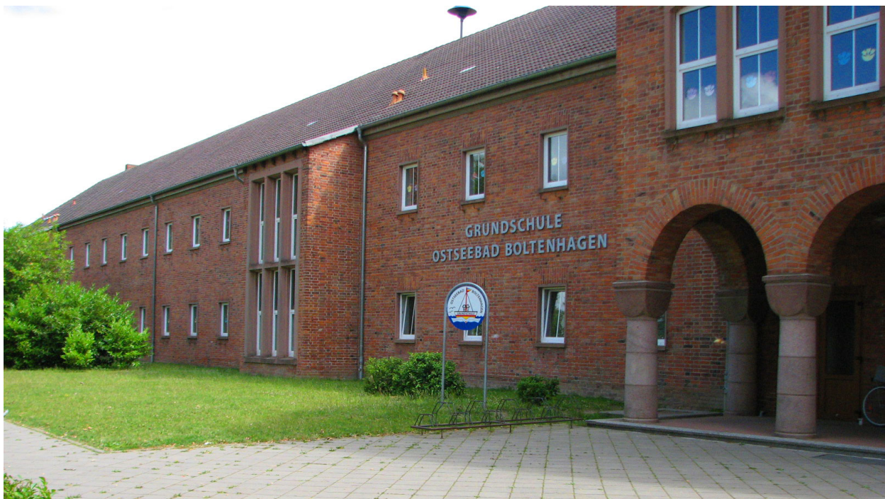
Abbildung 1: Ansicht Hauptgebäude Schule mit Haupteingang
