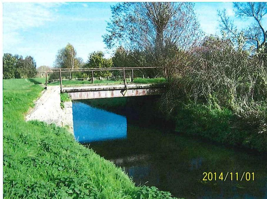
Bildinhalt: starker Bewuchs oberwasserseitig rechts, hinten rechts
