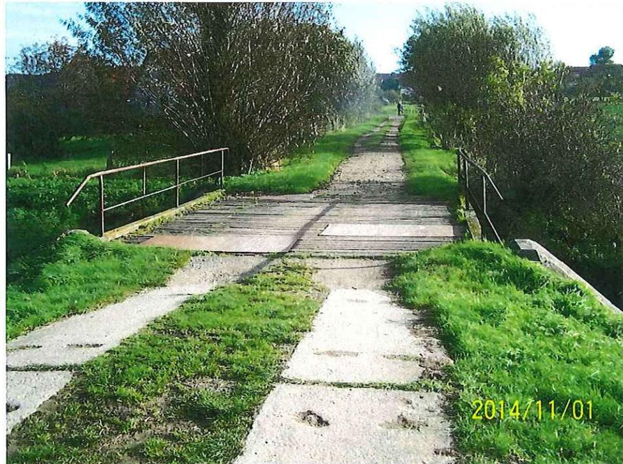
Bildinhalt: Geländer nicht fachgerecht, Löcher im Bohlenbelag mit Blechplatten abgedeckt, Fahrbahnübergang abgesackt
