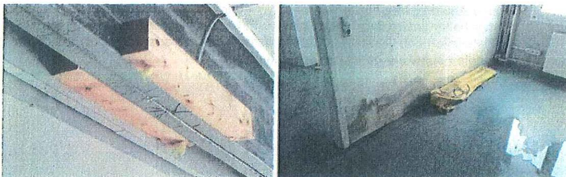
Eingedrungene Feuchtigkeit im Dach, Feuchtigkeitsschäden an der Wand und dem Fußboden
