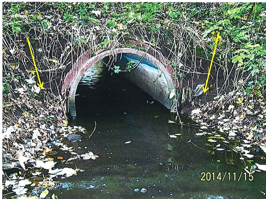
Schutz gegen Umläufigkeit verfault
