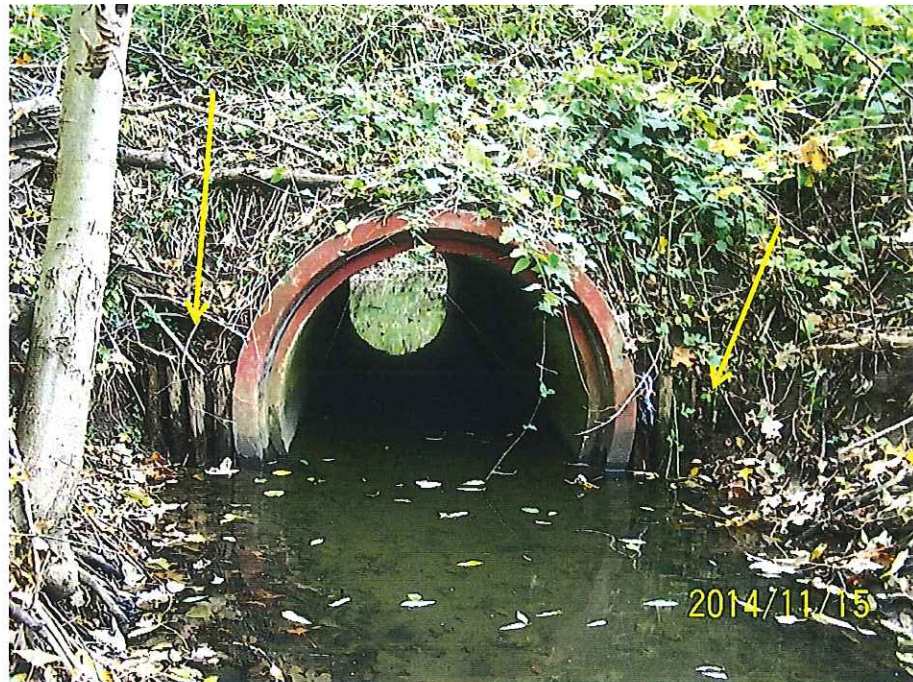
Schutz gegen Umläufigkeit verfault
