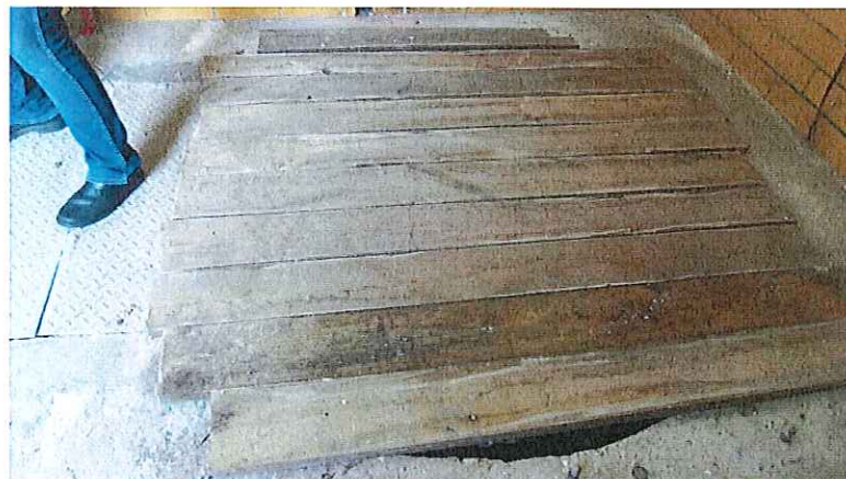
Abdeckung Armaturenschacht
