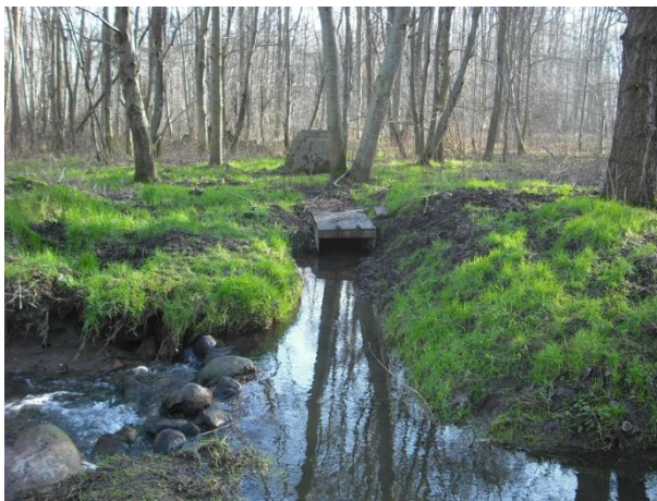
Abbildung 6-1: Einlauf in die Rohrleitung zum Schlossteich
