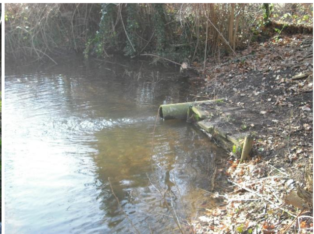
Abbildung 6-2: Zulauf DN200 aus dem Zierower Bach
