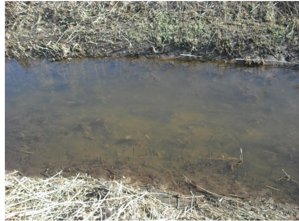
Abbildung 3-7: Schluffige Sedimentablagerungen zwischen Station 1+039 und 0+200 bei Fließgeschwindigkeiten zwischen 0,08 – 0,03 m/s
