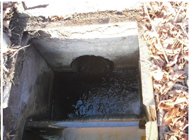
Abbildung 6-4: Ablauf aus dem Schlossteich DN500
