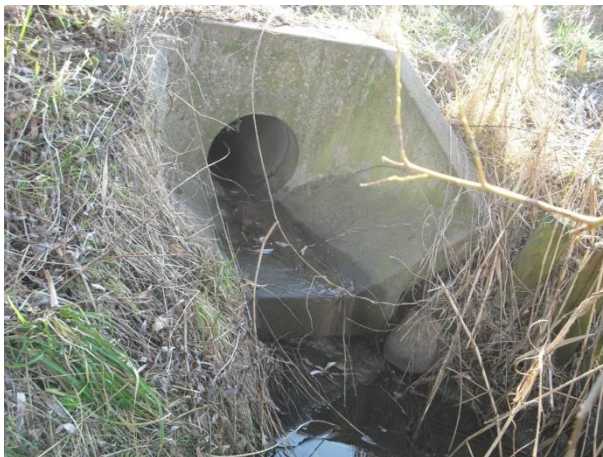
Abbildung 6-3: Zulauf DN300 aus dem Siedlungsgebiet
