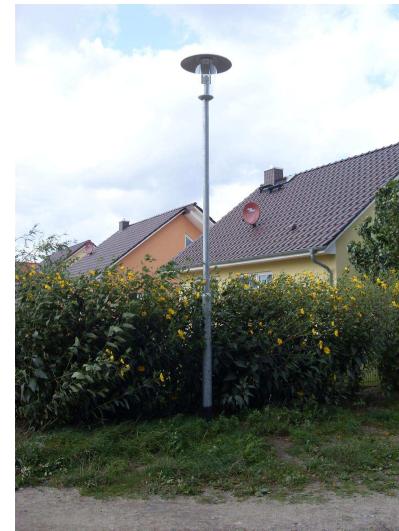
Bestandsbeleuchtung Zufahrt PP LED Mastleuchte, Typ Eva II, Leipziger Leuchten
