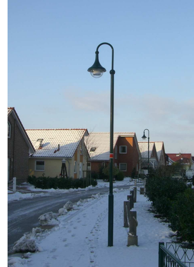
Bestandsbeleuchtung Am Reek LED Mastleuchte, Typ Nadja III, Leipziger Leuchten
