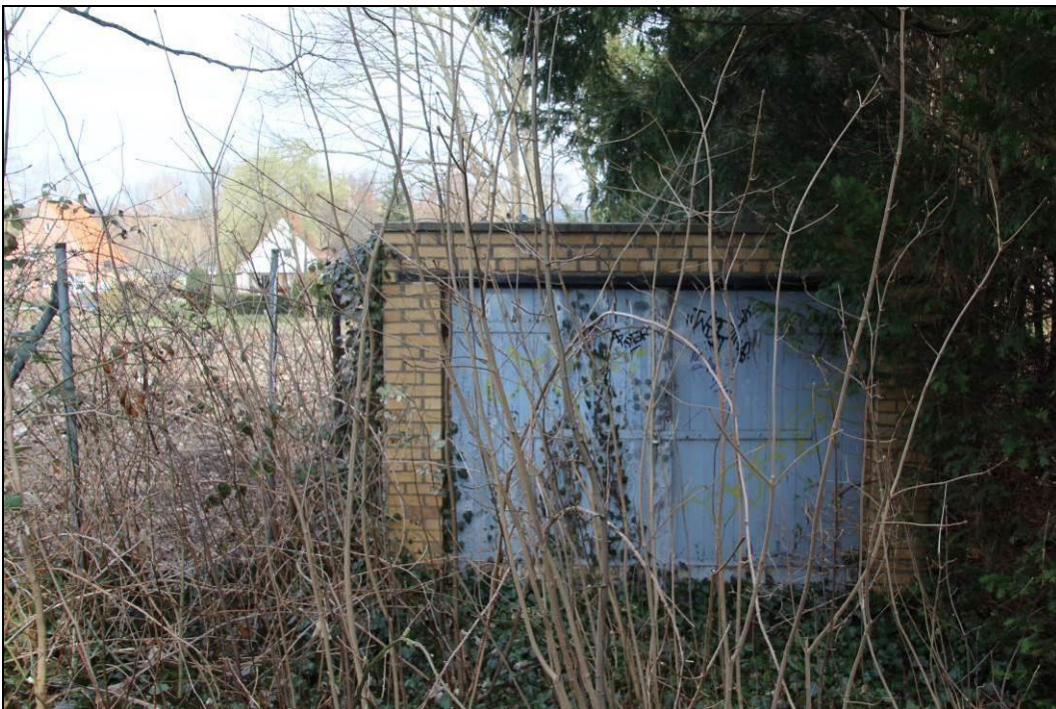
Abbildung 13: Garage im Plangeltungsbereich.
