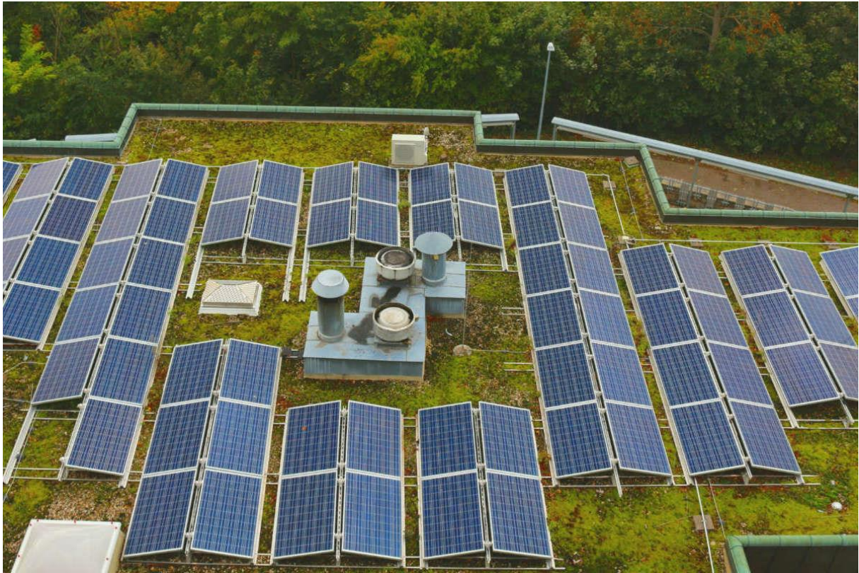
Abb. 12: Aufgeständerte PV-Anlagen auf einem Gründach, Quelle: https://www.enbw.com/blog/energie-wende/solarenergie/photovoltaik-auf-dem-flachdach-geht-das/
