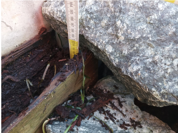
KLWI902_B_2023S1_AUFLAGERHOLZ-VERMODERT
