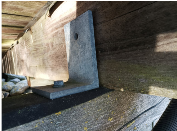
KLWI_902_A_FEHLENDE-VERSCHRAUBUNG
