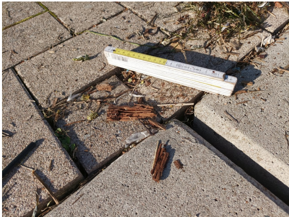
KLWI902_B_2023S1_ANFANG-PFLASTER ABGESACKT
