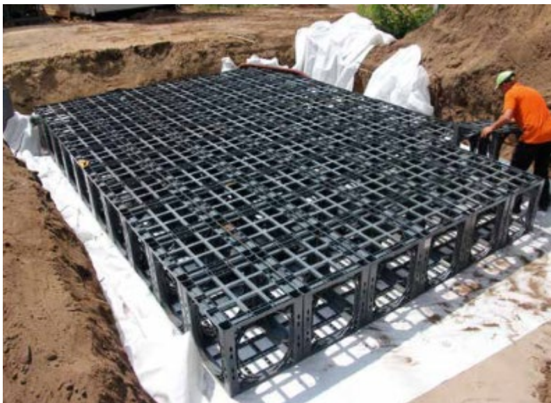
Abbildung 3: Beispiel Verlegung Kunststoffelemente (Quelle Funke Gruppe)
