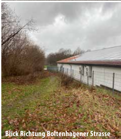
Blick von Am Turnplatz Richtung Boltenhagener Strasse
