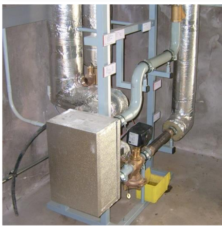
Abb. 31: Wärmeübergabestation
