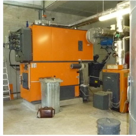
Abb. 28: Holz-Hackschnitzelkessel
