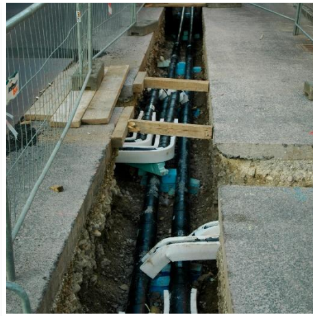
Abb. 30: Nahwärmeleitungen
