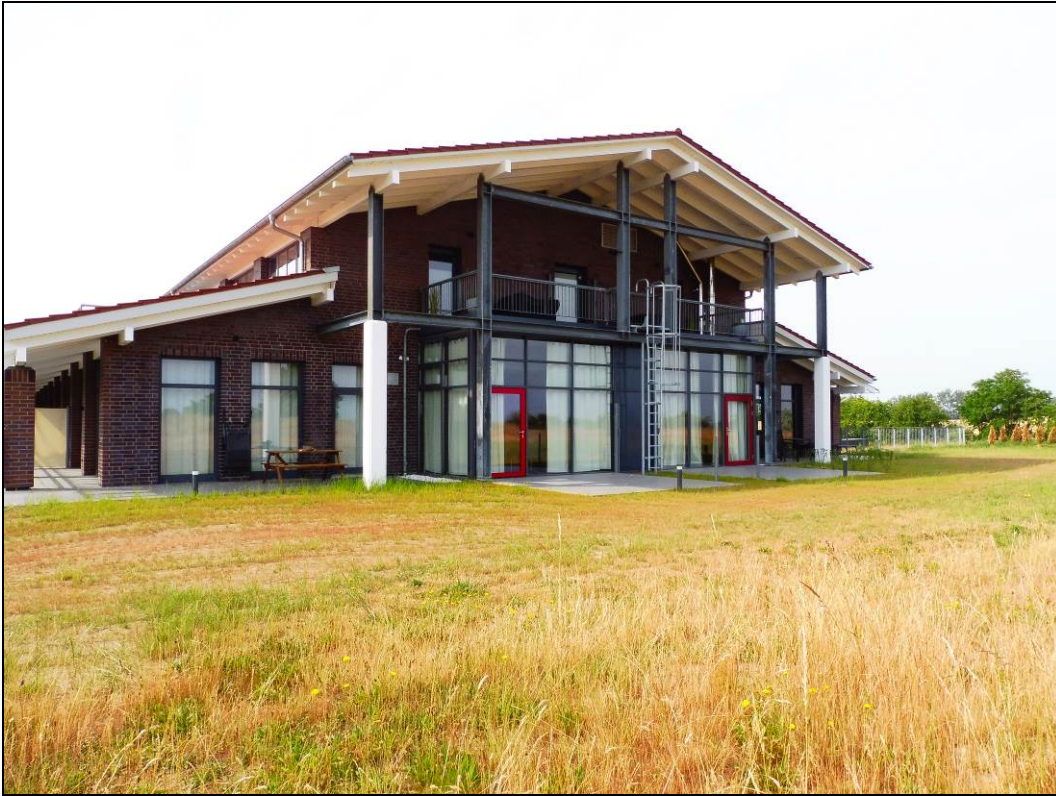
Abbildung 4: Ansicht des Gebäudes aus Richtung Norden.
