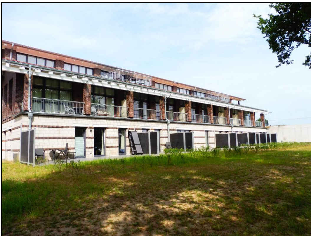
Abbildung 3: Ansicht des Gebäudes aus Richtung Südosten.
