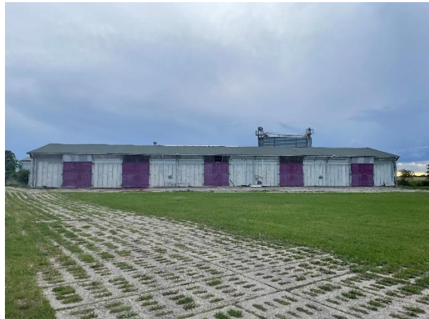
Blick von Norden auf eine bestehende Halle; eig. Aufn.
