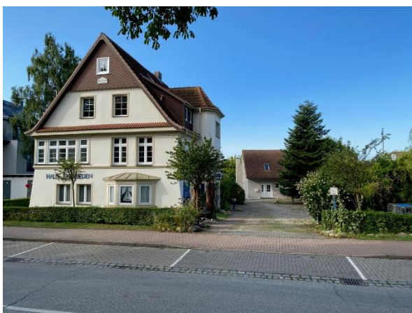
Abb. 2: Vorhandene Bebauung innerhalb des Plangebietes, eigene Aufnahme.
