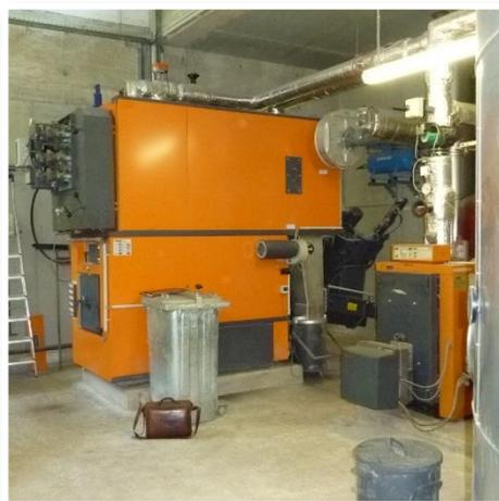
Abb. 20: Holz-Hackschnitzelkessel
