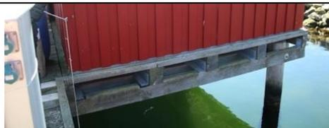
**Fischerhütte** Außenansicht, i.O., Außenkante bewittert, dadurch entstehen an den Außenkanten Schädigungen.
