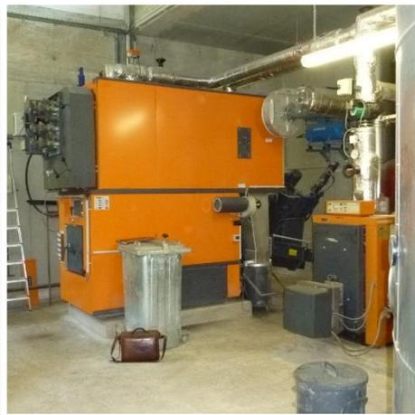
Abb. 27: Holz-Hackschnitzelkessel
